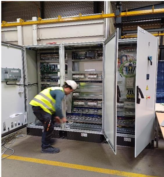
Intervention d'un de nos technicien électricien sur un raccordement d'armoire électrique à la suite du déplacement de celle-ci faisant suite au remplacement d'un robot en milieu aéroportuaire.
